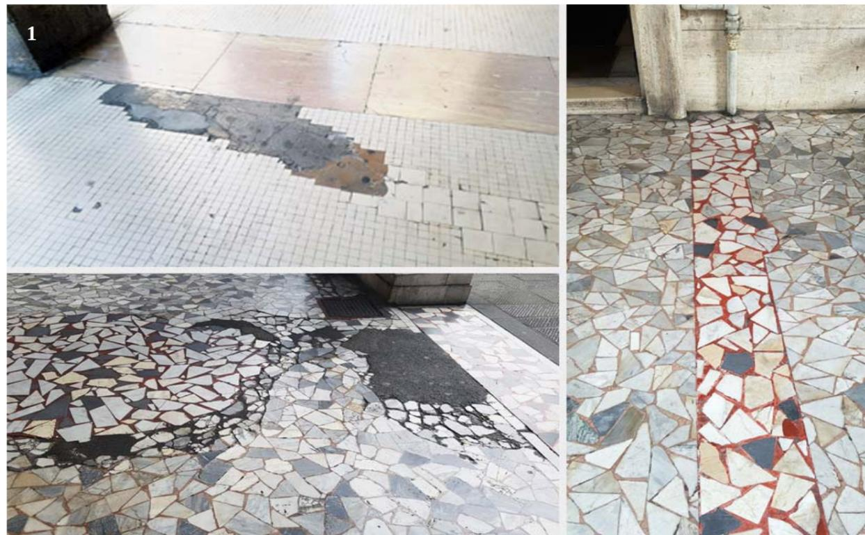
Il rilievo visivo dello stato di conservazione della pavimentazione (imm. 2) ha permesso di redigere una tavola (allegata al progetto) dove si evince il complessivo valore del degrado. Nello schema sotto riportato è rappresentato un estratto di questa tavola, ad un veloce sguardo, è possibile comprendere l'estensione della pavimentazione degradata da sostituire (colori caldi) rispetto a quella che potrebbe rimanere (colori freddi).
