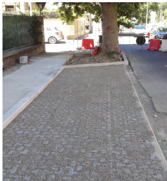
Fig. 14_Pavimentazione drenante su spazi di parcheggio di Via Montebello a Livorno
