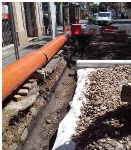
Fig. 14_Pavimentazione drenante su spazi di parcheggio di Via Montebello a Livorno
