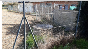
Recinzione campi stato manutentivo buono
