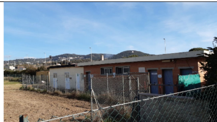
Fabbricati spogliatoio in muratura e locali tecnici
