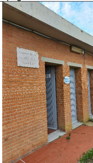
Locali spogliatoio fronte - ingressi
