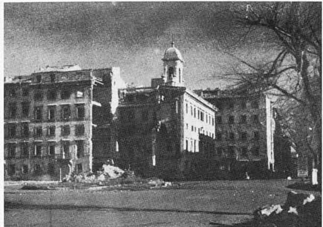
1949, 24 dicembre - Completati i lavori di ricostruzione l'Amministrazione Municipale ritorna nella tradizionale sede di piazza Grande. Nella foto, una visione del Palazzo Comunale prima dei lavori di restauro.
