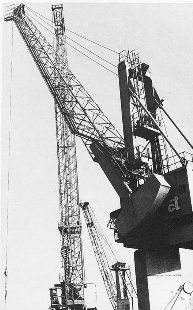
1986 - Si prospetta la necessità di individuare una soluzione che tenga conto delle esigenze di ammodernamento del Cantiere e di un più razionale e qualificato uso delle aree e delle strutture.
