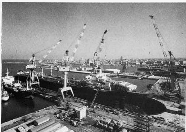
1975, 30 aprile - Nella grande vasca del nuovo Bacino di Carenaggio entra la prima nave per i necessari interventi. Si tratta della «Hydrus» (160.000 tpi). L'impianto «decolla» mentre ancora si lavora alle opere complementari ed alla pavimentazione. Successivamente il Bacino ospita, tra le altre, la «S. Giusto» (227.000 tpi), la «Furness Bridge» (168.000 tpi), la «Agip La Spezia» (140.000 tpi), la «Koyali» (270.000 tpi), la «Beaumont» (290.000 tpi). Il moderno bacino livornese si rivela una struttura fortemente competitiva nello scacchiere mediterraneo.
