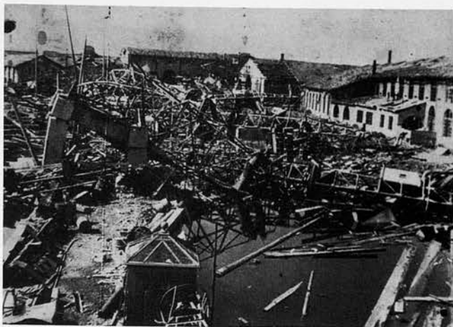
1944 - Il Cantiere Navale, l'industria più importante, simbolo dell'operosità e della vita cittadina, a causa degli eventi bellici è ridotto ad un ammasso di rovine.
