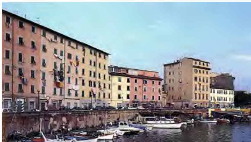
Abitazioni e cantine lungo il fosso Reale
